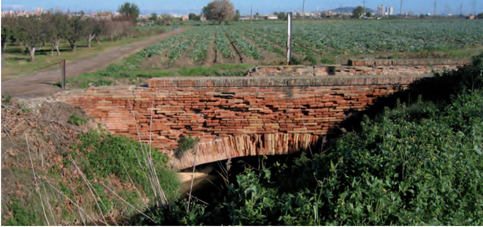
FIGURA 51. Pont original sobre el canal de la Dreta al seu pas per la zona agrícola de Sant Boi. La construcció de nombrosos ponts al llarg del seu recorregut va ser bàsica per a poder facilitar les comunicacions entre les terres que quedaven segregades pel pas del canal. En la imatge, hi podem veure alguns dels conreus que han donat fama a l'agricultura de Sant Boi, com són les carxofes i els fruiters (especialment pomeres).
