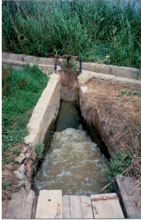
FIGURA 44. Imatge corresponent a una fibla deixant passar l'aigua cap a una fillola o regadora. El sistema de reg es basa en un sistema jeràrquic de séquies que es van subdividint fins a conduir l'aigua als camps.
