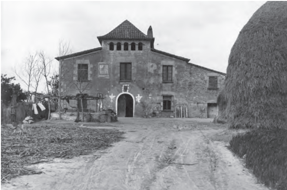
FIGURA 32. La masia de Can Parellada de la Boïga patí molt els efectes dels aiguats i de la inundació del setembre del 1971. Amb la canalització posterior s'enderrocà la masia, ja que era al llit actual del riu.
