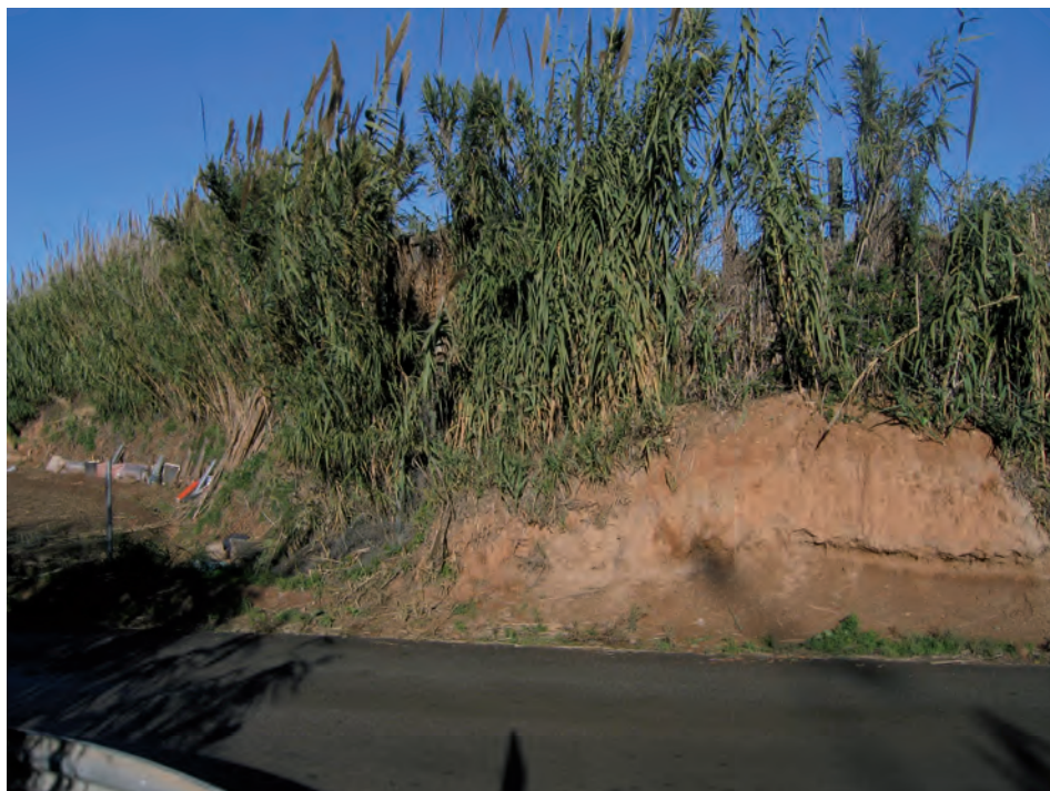
FIGURA 31. Vista del segon marge de protecció al sector de la Ribera del Prat. Aquest marge va ser construït a partir del segle XVI pels pagesos aportant terra dels seus camps. A manera de pòlder paral·lel al curs del riu, aquest marge pretenia frenar l'avanç de l'aigua en cas de desbordament. El primer marge era a tocar del riu i, de fet, n'emmarcava el llit. Al marge esquerre va existir un marge de protecció semblant, conegut amb el nom de terraplè , situat també paral·lel al riu. Anava des de Cornellà fins al terme de l'Hospitalet.
