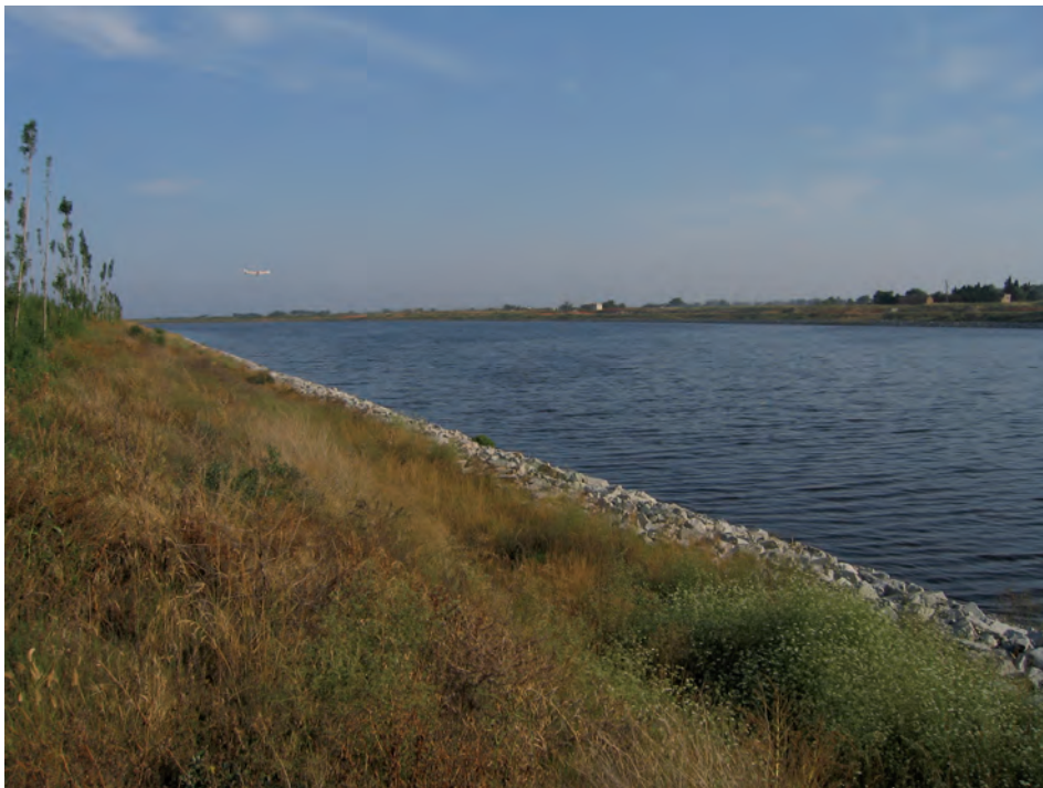
FIGURA 76. Nova llera del Llobregat al seu darrer tram just abans de desguassar al mar.
