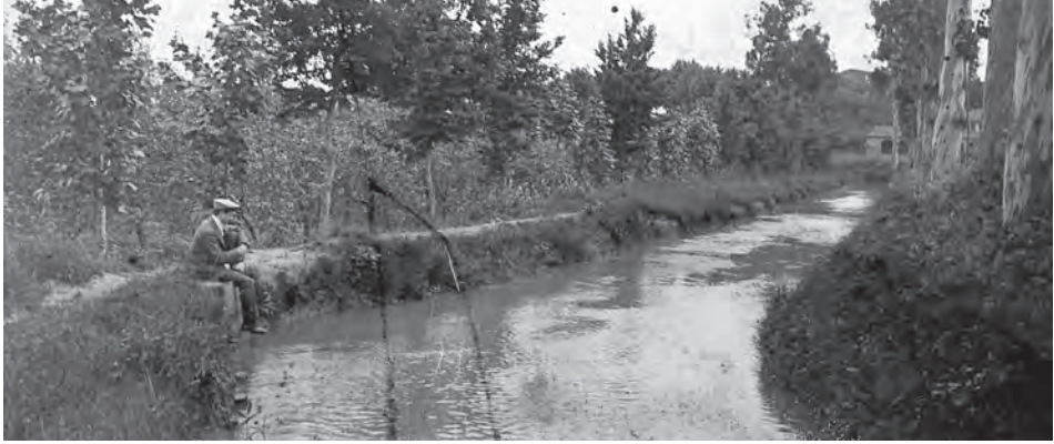
FIGURA 49. Imatge bucòlica del canal de la Dreta a la dècada dels anys vint del segle passat al seu pas per Sant Boi. En la imatge el canal se'ns presenta amb el seu cabal màxim, aproximadament de 5 m 3 /s a l'altura de l'estació del carrilet. Una abundant vegetació acompanyava les ribes del canal. Els marges també eren aprofitats com a camins, i, a causa del seu traçat rectilini entre el Prat i Sant Boi, el camí pel marge del canal era més directe que no pas alguns dels camins habituals de la Marina.
