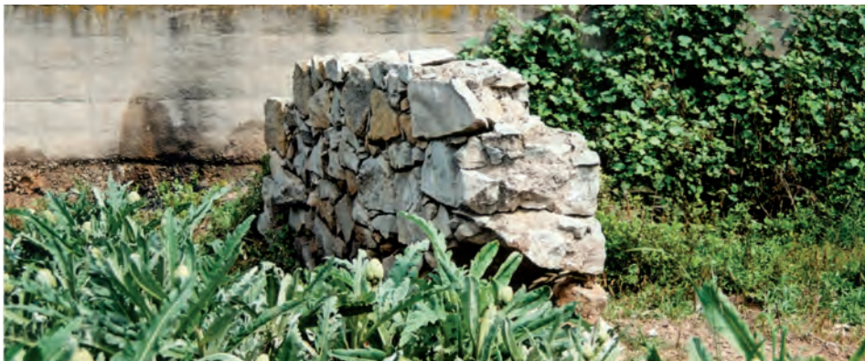
FIGURA 28. Resta de paret del clos construït amb pedra de Montjuïc.
