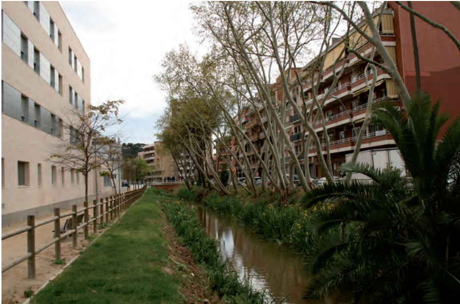
FIGURA 58. Pas del canal de la Dreta per Sant Boi. Les vores del canal han estat enjardinades amb arbres i plantes pròpies de zones humides, com el lliri groc.
