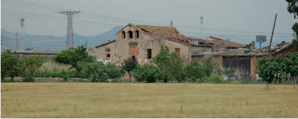
FIGURA 41. Paisatge de secà, el paisatge del passat al Delta actual. Aquesta imatge correspon al darrer espai agrícola de la Marina de l'Hospitalet. S'hi observa Cal Masover Nou i, enfront, cereals ja segats al començament d'estiu. Abans de l'arribada de l'aigua dels canals i les seves filloles, aquest era el color dominant dels camps de les marines de Sant Boi, l'Hospitalet o Viladecans.
