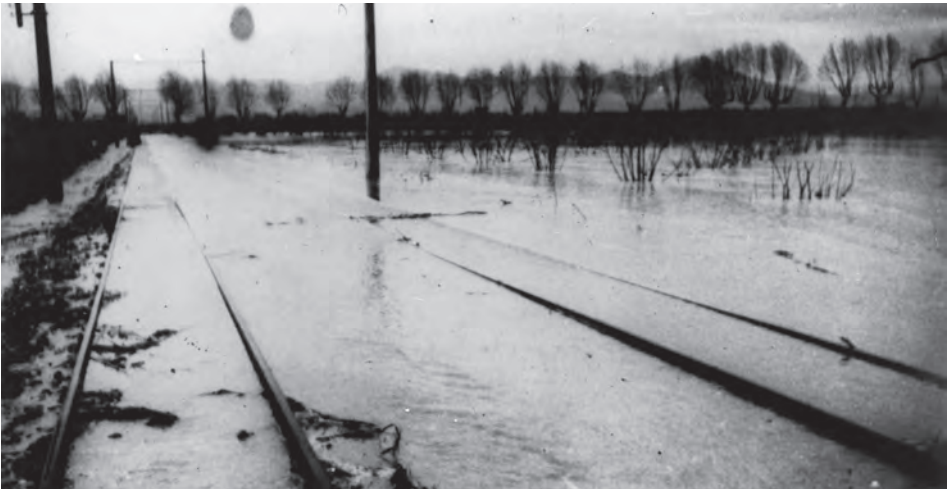
FIGURA 36. Les vies del carrilet completament negades, la qual cosa feia impossible la circulació de trens. La imatge correspon als aiguats ocorreguts al febrer del 1944. Comunicar-se a través del Delta ha estat un problema secular fins a l'arribada de vies de comunicació més ben fetes i consolidades, la canalització del llit del riu i, sobretot, la regulació de moltes crescudes mitjançant els embassaments situats a la seva conca.
