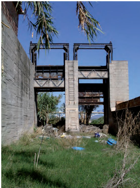
FIGURA 56. Rescloa de captació de l'aigua per part del canal de la Dreta al llit del riu Llobregat, al terme de Sant Vicenç dels Horts. En aquesta imatge les instal·lacions de captació ja no funcionaven i el canal s'alimenta d'una nova captació situada aigües més amunt. Aquestes instal·lacions, juntament amb la caseta del zelador de l'aigua situada a pocs metres d'aquest punt, són un important patrimoni històric i cultural que caldria preservar i que ens ajuda a explicar l'arribada de l'aigua i el regadiu al sud de la comarca del Baix Llobregat.
