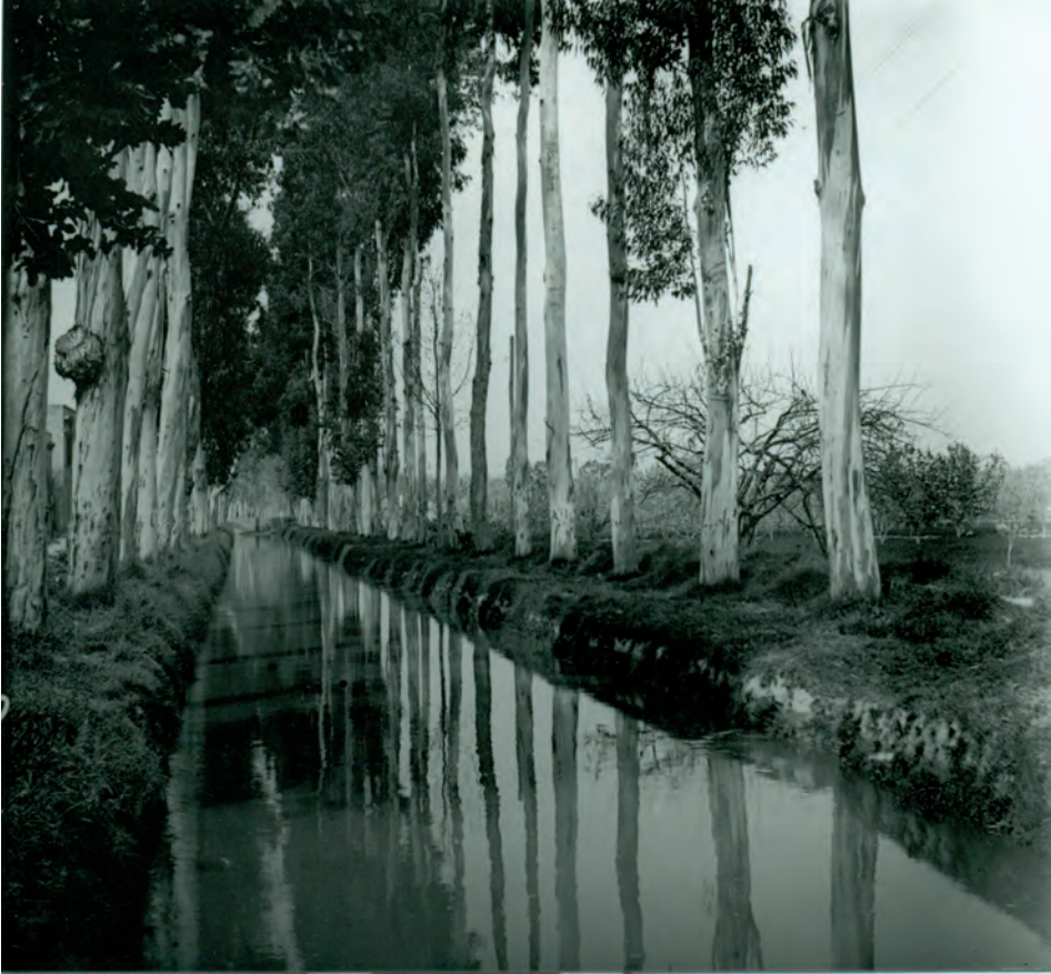
FIGURA 55. Vista del canal de la Dreta al seu pas pel carrer Antoni Pujades de Sant Boi a la primera meitat de segle XX. A l'esquerra, s'hi poden veure les cases del carrer, lloc on es troba també l'hospital psiquiàtric. El canal, flanquejat per fileres d'eucaliptus a cada marge, apareix amb un important cabal d'aigua. Al marge esquerre es distingeixen alguns fruiters. Actualment, en aquest mateix lloc hi ha diversos equipaments com els jutjats de Sant Boi o la comissaria dels Mossos.
