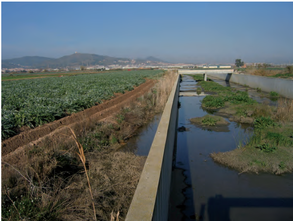
FIGURA 79. Imatge de la riera Roja canalitzada, on s'observen els dos ambients que condiciona. Al fons de la riera, malgrat que sigui cimentat, l'acumulació de sediments fins i tot dóna lloc al desenvolupament de comunitats d'herbes altes. Alhora, hi resta una franja humida entre la paret de ciment i els conreus propers.
