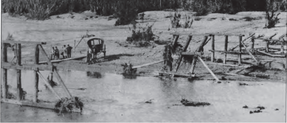
FIGURA 37. Les comunicacions es veien sovint greument afectades per les riudes. En la imatge del 1902 s'observa un dels ponts de fusta que es construïren a cavall dels segles XIX i XX i que sovint les aigües enfurismades del Llobregat s'enduïa. Les comunicacions eren encara molt febles al començament del segle XX.
