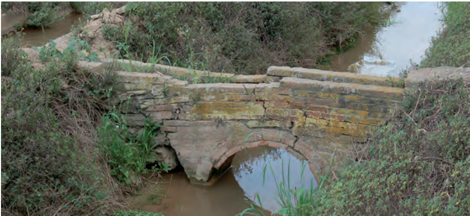
FIGURA 52. La complexitat del sistema de reg al Delta és ben visible en aquesta imatge. A la banda esquerra podem veure una fillola derivada del canal de la Dreta i com des d'aquest punt neix una regadora d'obra que travessa, mitjançant un petit aqüeducte, una pluvial. Al llarg del Delta trobem nombroses construccions lligades al regadiu que, com la de la imatge, es van deteriorant per falta de manteniment ja sigui per la seva substitució mitjançant altres canalitzacions o pel canvi d'usos de les terres abans regades.
